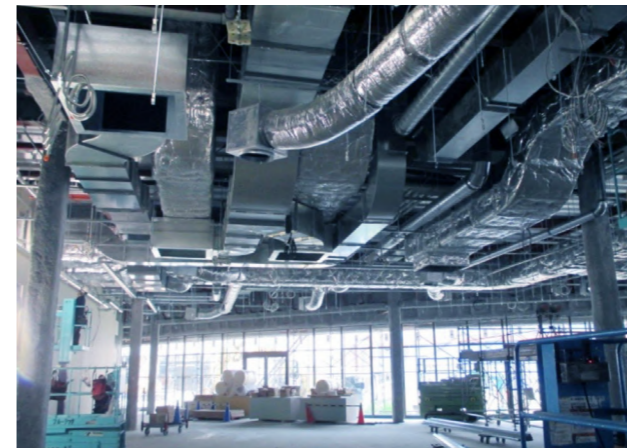
現場 建物内ダクト吊込状況
