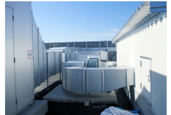
現場 屋上ダクト吊込状況
