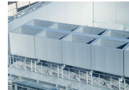
冷却塔用消音器
